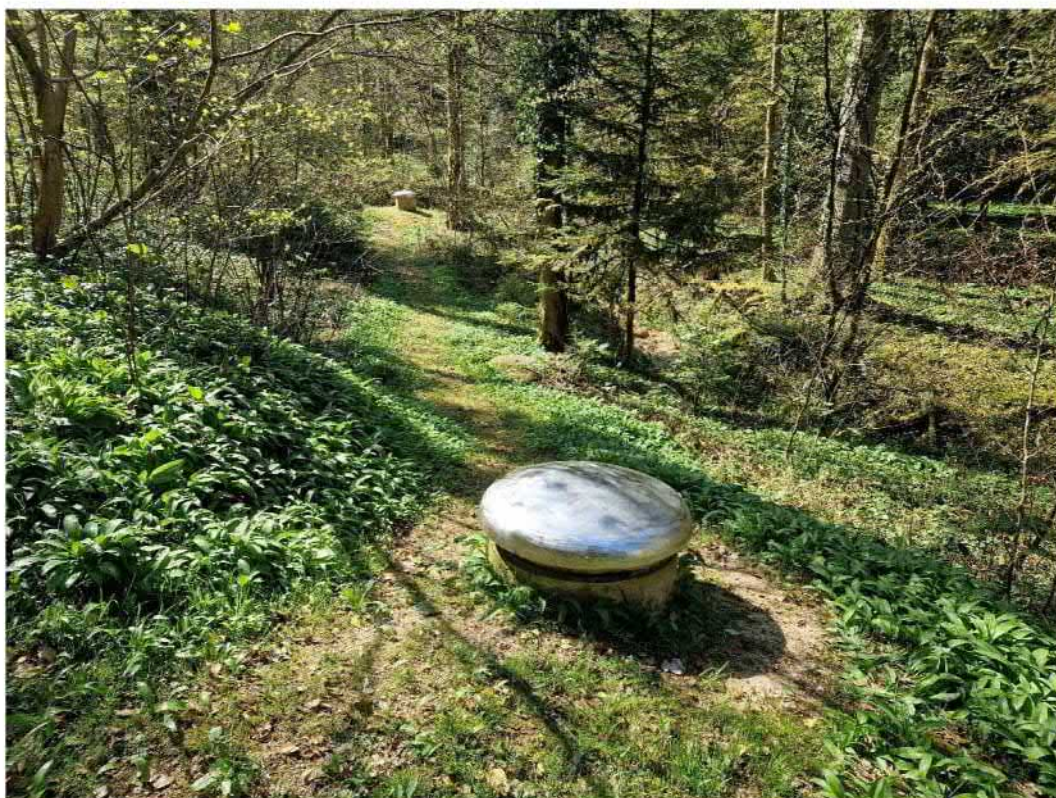
Foto 3: Schacht Quelle 2 (66.4.A) und 3 (66.3.A)
